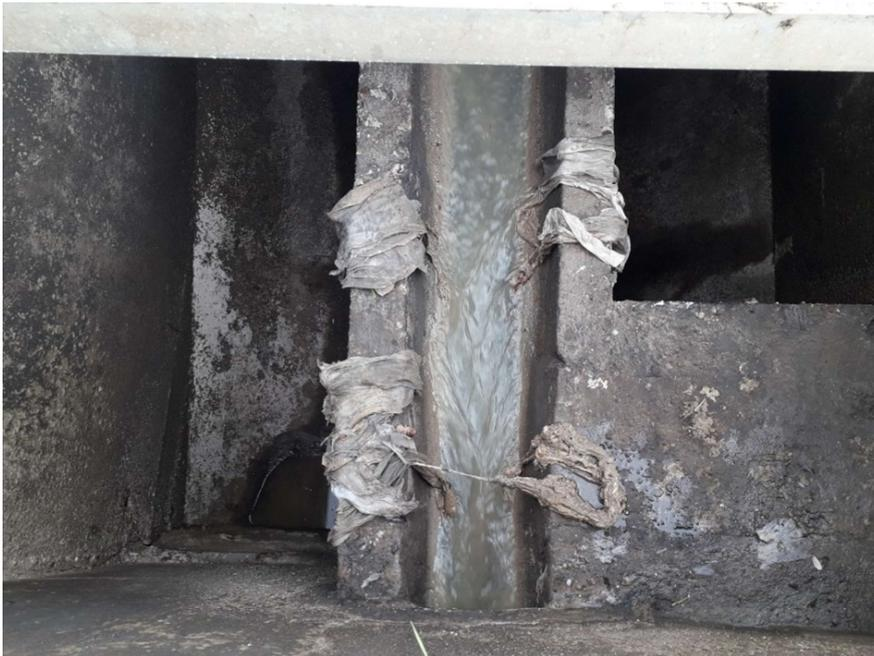
*Ecoulement d'un déversoir d'orage*
