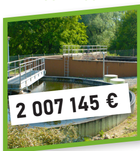
RÉSEAUX ET ÉQUIPEMENTS D'ASSAINISSEMENT
