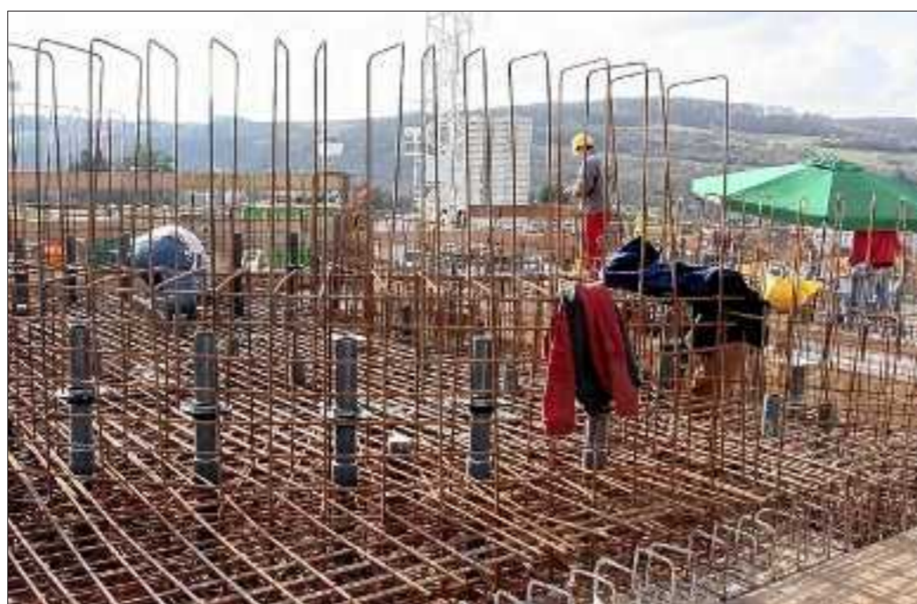
D'imposantes structures en ferraille sont en cours de pose pour accueillir le béton armé.
