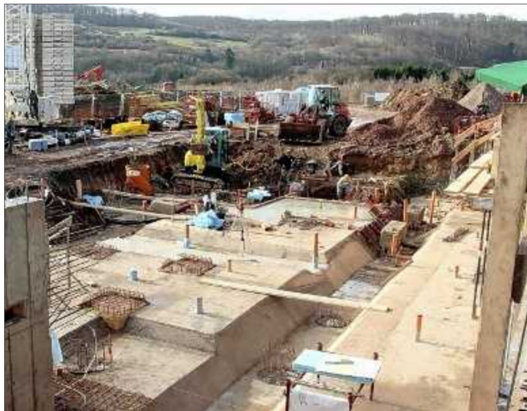
Le sous-sol donne déjà un aperçu de la répartition du futur bâtiment central.
